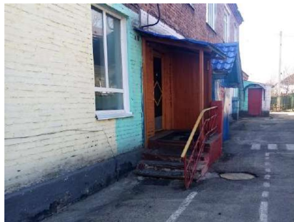
Фото № 4. Лестница (наружная)
